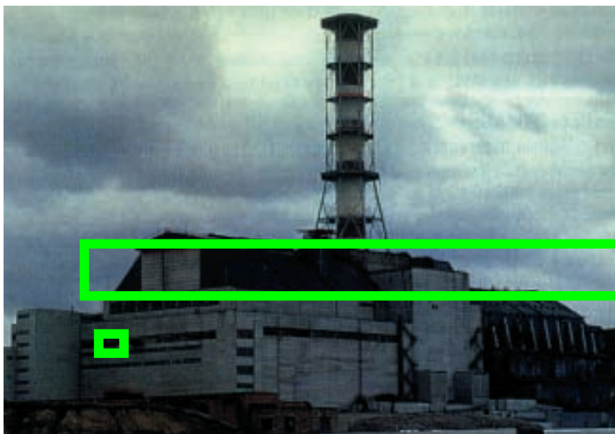
1. LE RÉACTEUR 4 QUI A EXPLODÉ est visible à droite, le réacteur 3, à gauche, étant toujours en fonctionnement. Après l'explosion, le réacteur 4 a été recouvert d'un sarcophage qui confine les radio-isotopes les plus dangereux.
