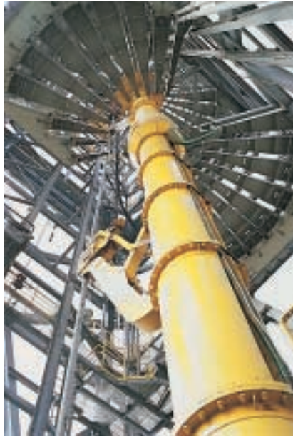
3. LE PROGRAMME KTB a suscité la mise au point de techniques nouvelles qui ont été reprises par les industries pétrolières. Ainsi le système de manutention automatique des tiges (en jaune) comporte des bras à commande hydraulique qui saisissent les sections de 40 mètres de tiges de forage vissées ensemble et les déposent dans la tour de forage, au niveau de la plate-forme digitée (en haut à droite). Cette installation a réduit de près de 30 pour cent la durée des opérations de démontage et de réassemblage des trains de tiges, lors de l'échange des trépons de forage usés.
