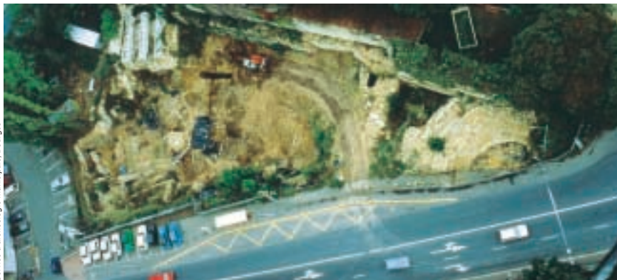
Vue aérienne de la Grosse Tour de Bourges (dans l'angle, à droite), avant la construction de l'hôtel de ville. Le dépotoir fouillé est à sa base.
