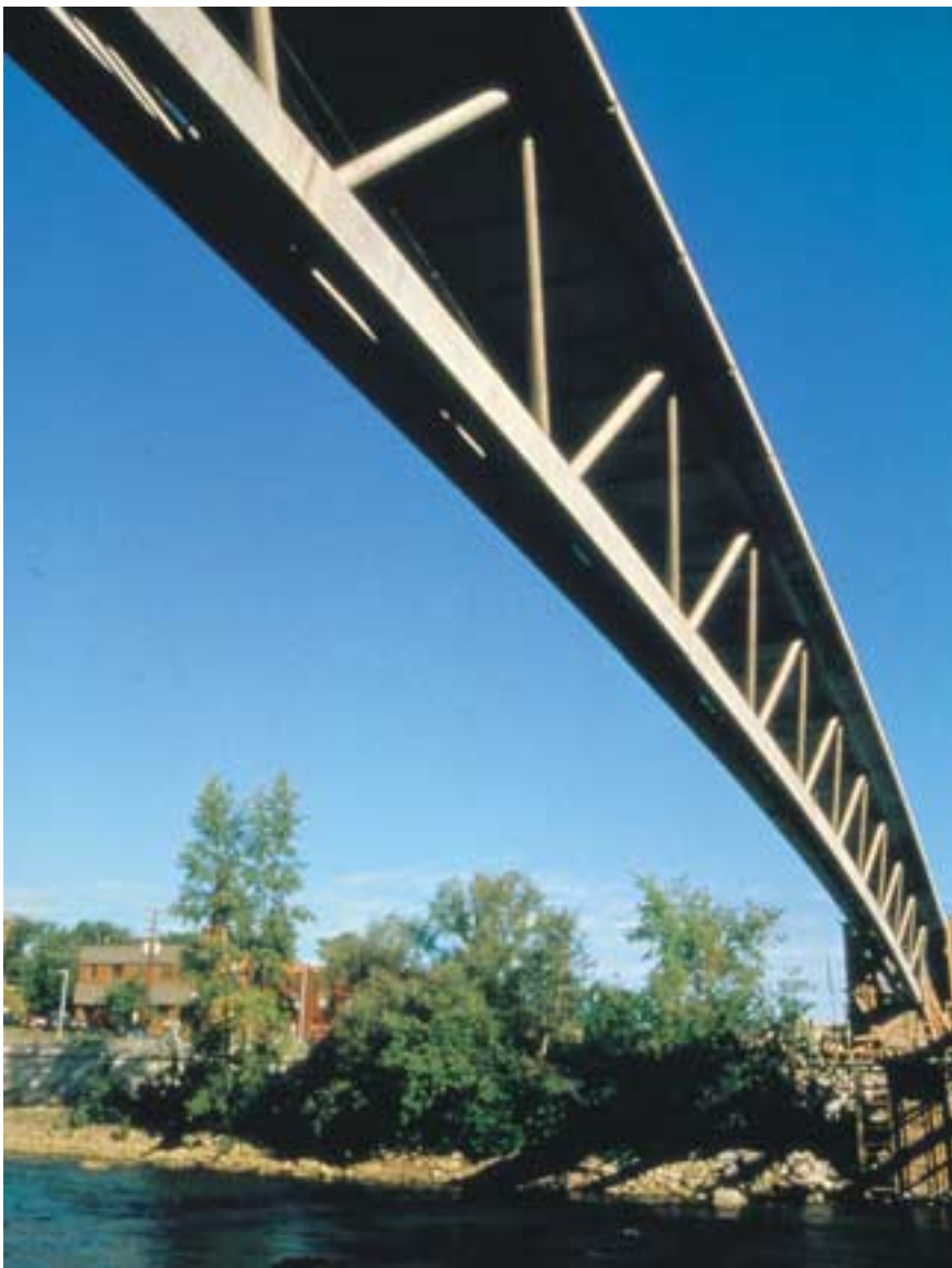
5. CETTE PASSERELLE CONSTRUITE À SHERBROOKE, au Canada, est le premier ouvrage réalisé à partir de «béton de poudres réactives». Dans ce béton, les granulats les plus gros sont des grains de sable. En outre, la porosité est réduite (l'empilement granulaire est optimisé). Après le gâchage et le moulage, on traite le béton thermiquement afin d'activer la réaction pouzzolanique, qui réduit la concentration en chaux et augmente la proportion de silicate de calcium hydraté. De surcroît, des fibres métalliques noyées dans le matériau donnent à celui-ci de une ductilité utile pour la résistance au vent.
