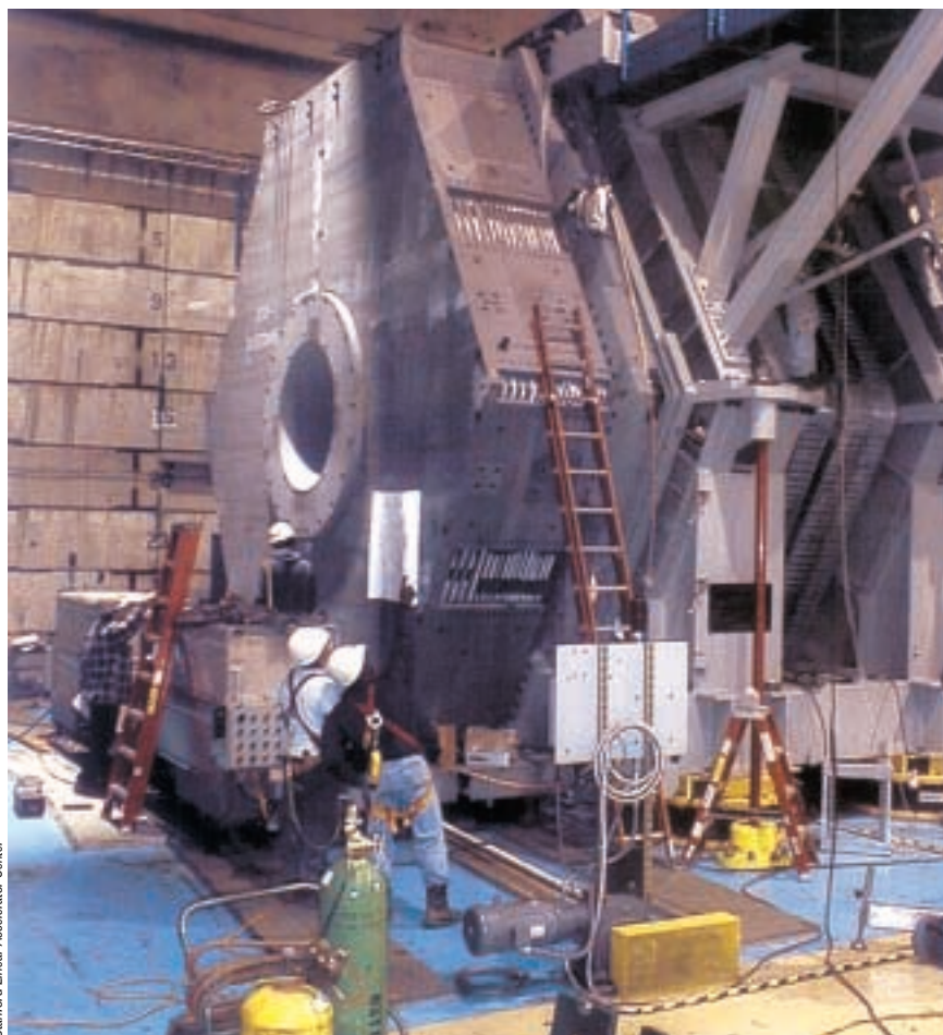
4. LE DÉTECTEUR BABAR de l'Université de Stanford, construit dans le cadre d'une collaboration internationale, enregistrera les désintégrations des mésons B et permettra ainsi d'éclaircir nos connaissances sur la violation CP.
