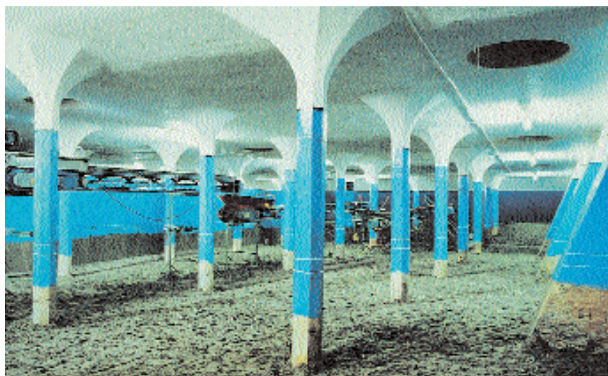
8. LES COLONNES ÉVASÉES de l'immeuble Filter (construit par Maillart en 1912, à Rorschach, en Suisse), se fondent dans le plafond, c'est-à-dire dans les dalles de l'étage supérieur, qu'elles soutiennent à elles seules, sans poutres horizontales.
