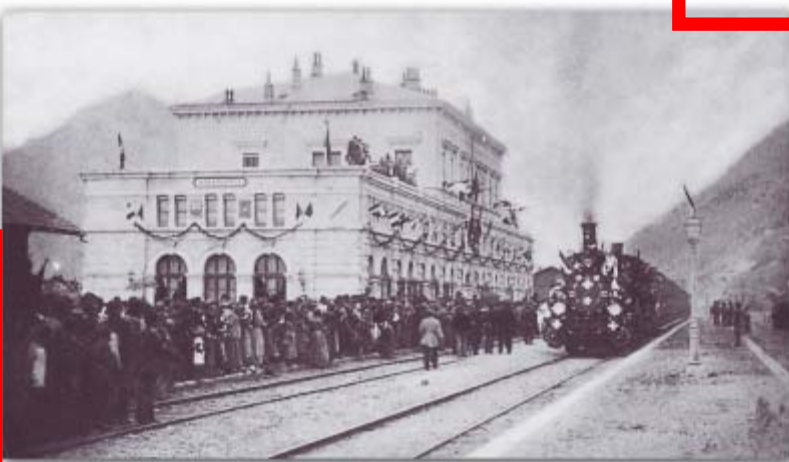
2. Le 23 mai 1882, le premier train à avoir emprunté le tunnel du Saint-Gothard atteint Bellinzona.
