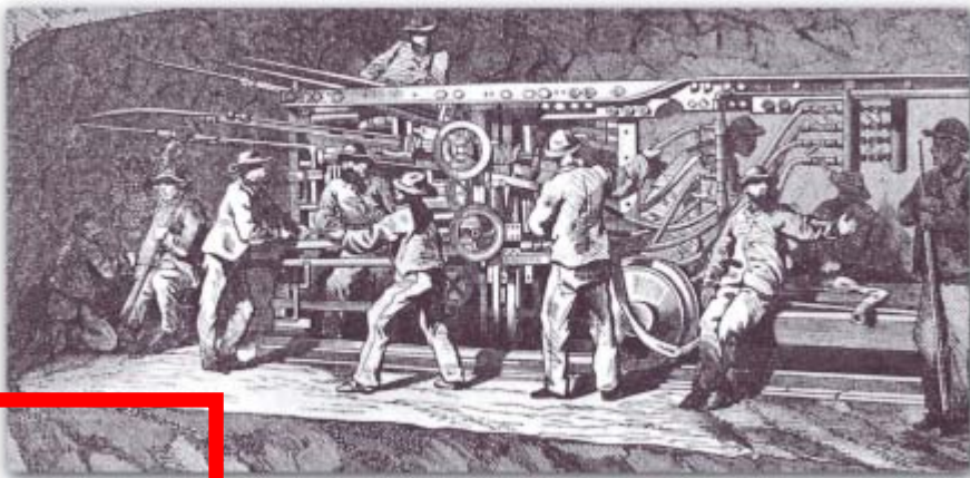
1. Cette perceuse a été conçue en France et utilisée pour la première fois sur le chantier du tunnel du Mont-Cenis, qui relie l'Italie à la France et qui a été inauguré en 1871.
