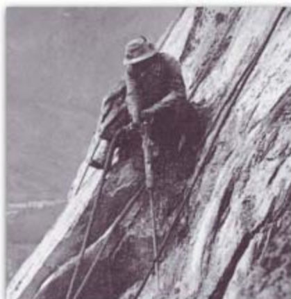
5. Sur le chantier du tunnel du Simplon, les mineurs ont percé les premiers trous de mine accrochés à la paroi rocheuse par des cordes
