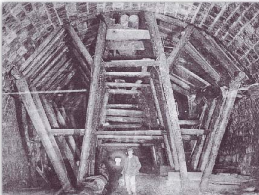
5. Opération de consolidation du tunnel de Lötschberg en 1914
