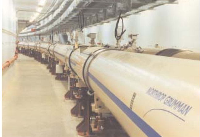
5. L'ANNEAU DU COLLISIONNEUR du Laboratoire de Brookhaven, nommé RHIC, est enfoui dans un tunnel à quatre mètres de profondeur. Des paquets d'ions d'or s'y déplacent à une vitesse très proche de celle de la lumière, en suivant un anneau de près de quatre kilomètres de circonférence.
