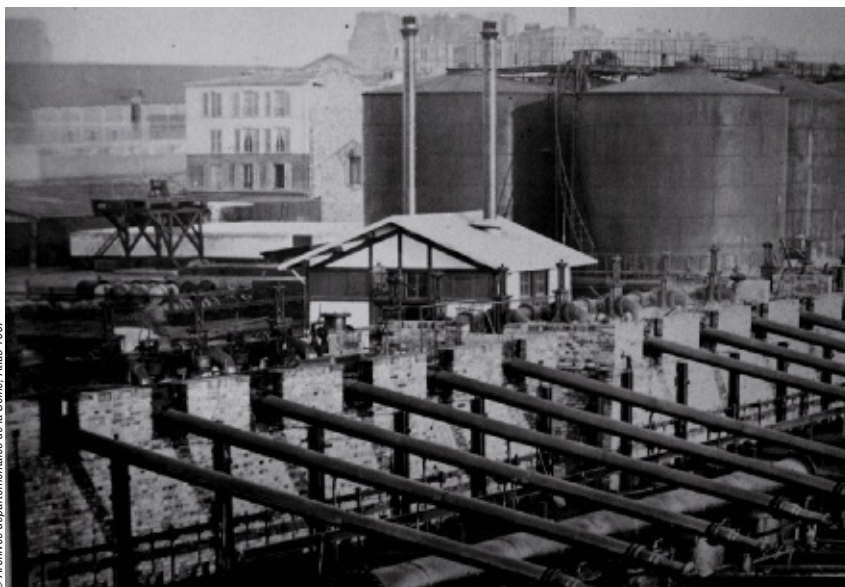
3. L'USINE À GAZ DE LA VILLETTE en 1878, entourée d'habitations.
