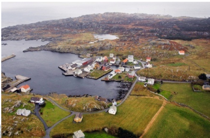
1. SUR L'ÎLE D'UTSIRA, EN NORVÈGE, l'électricité qui alimente les habitations est produite par deux éoliennes. Le surplus d'énergie est stocké sous forme de dihydrogène non loin des éoliennes, puis reconverti en électricité lorsque le vent est insuffisant.
