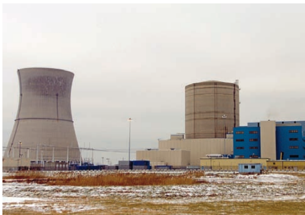
La centrale nucléaire de Davis-Besse (Ohio, États-Unis).
