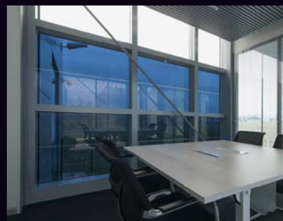
3. CETTE FENÊTRE CONTIENT DES MATÉRIAUX ÉLECTROCHROMES (ici des composés inorganiques). Elle peut être commutée d'un état incolore à un état bleu foncé. Le choix de la tension appliquée permet de moduler le degré d'assombrissement ou de revenir à l'état clair, le système étant réversible.
