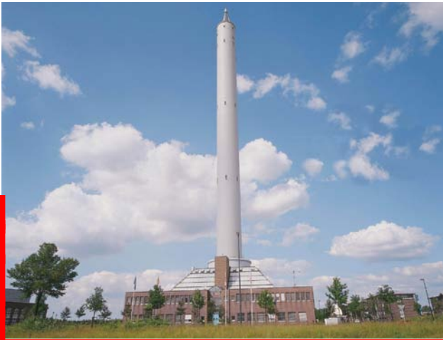
5. LA TOUR D'IMPESANTEUR DE BREME (à gauche) a été construite pour réaliser des expériences de chute libre à l'intérieur d'une capsule (à droite) de 80 centimètres de largeur tombant dans une colonne de 110 mètres de haut, où règne le vide. En bas, l'impact est amorti par un réceptacle rempli de petites billes de polystyrène. Les quelques cinq secondes de chute libre, donc d'apesanteur, ainsi créées servent le plus souvent à tester des dispositifs spatiaux, mais elles peuvent aussi être mises à profit pour tester le principe d'équivalence.
