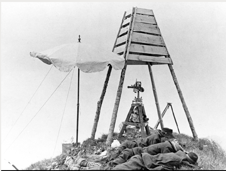
S OUS UN SIGNAL VISIBLE DE LOIN (ici en bois), les alpinistes, mesures accomplies, se reposent près d'un théodolite (instrument mesurant des angles dans les plans horizontal et vertical afin de déterminer une direction) et d'un parasol visant à éviter les reflets.
