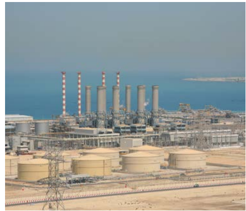
Une usine de dessalement de l'eau de mer à Dubaï, aux Émirats arabes unis.
