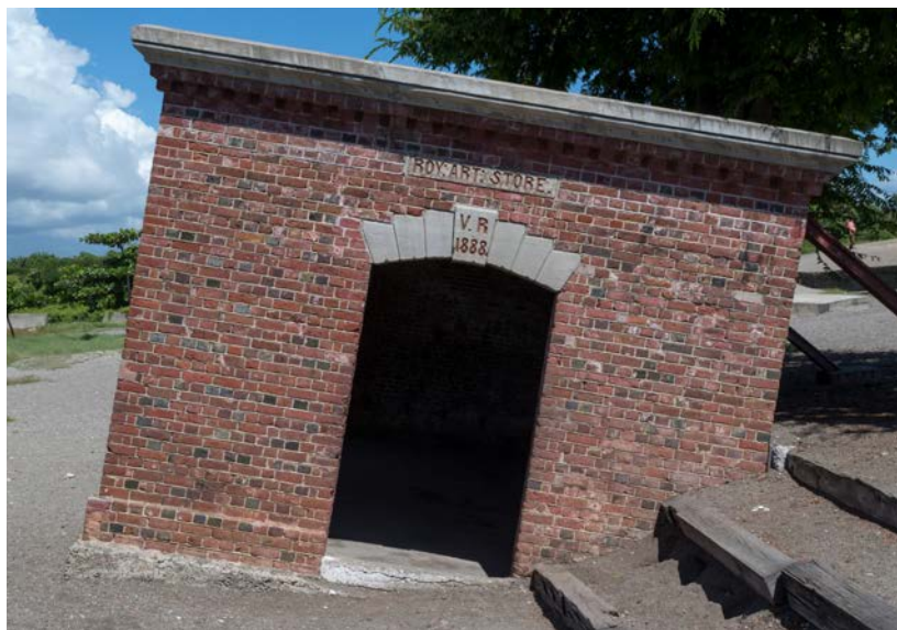
La Giddy House est une ancienne artilerie, construite en 1888 à Port-Royal, en Jamaïque. La portance du sol liquéfié lors du séisme de 1907 n'a pas été suffisante pour soutenir le poids du bâtiment.
