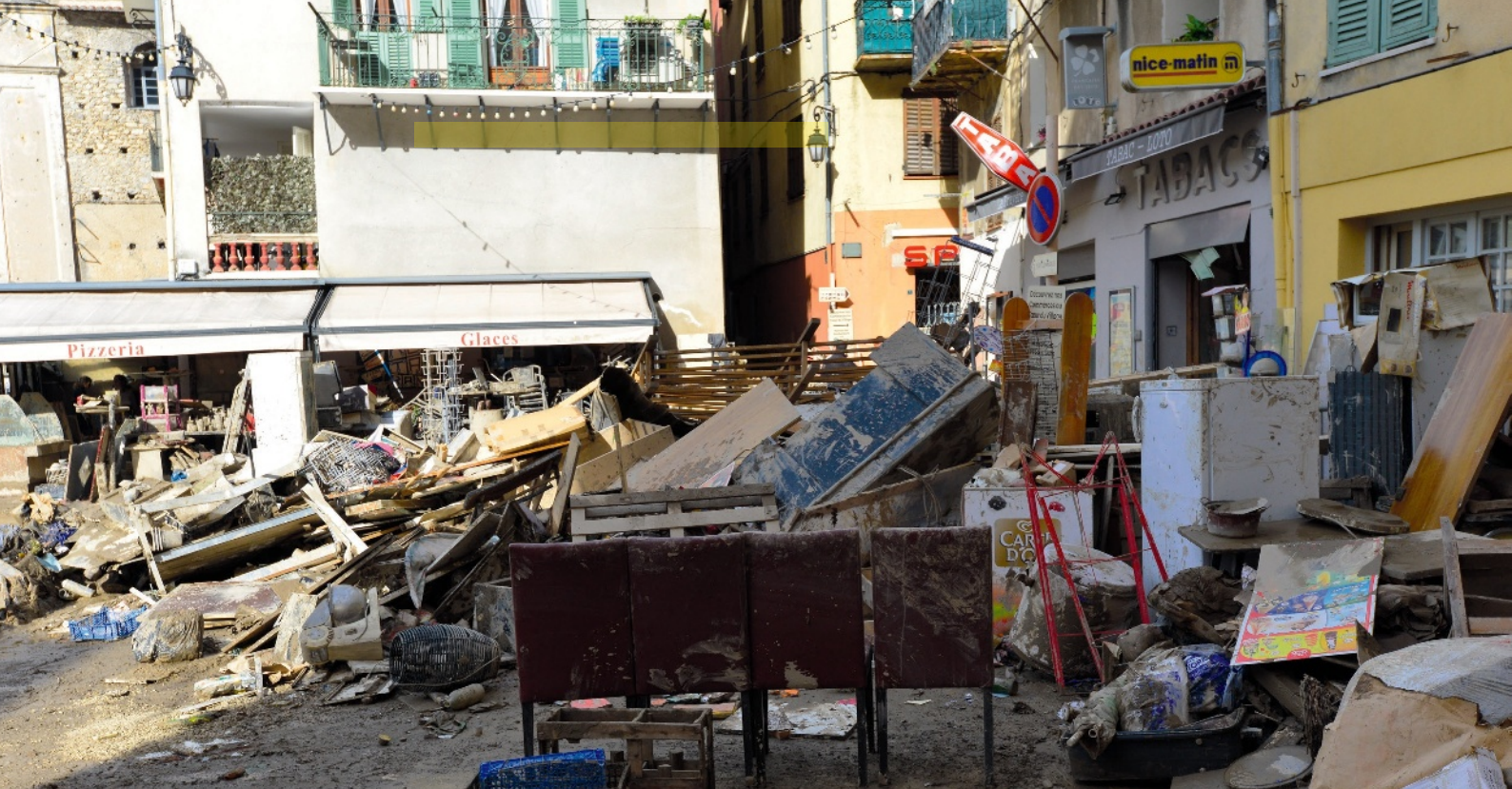
Les dégâts d'une crue à Breil-sur-Roya.
