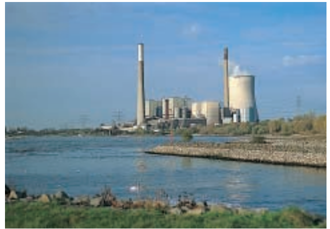
région du fleuve, ici au pied de l'usine de production d'électricité de Voerde, dans le bassin industriel de la Ruhr, est bien plus propre.
