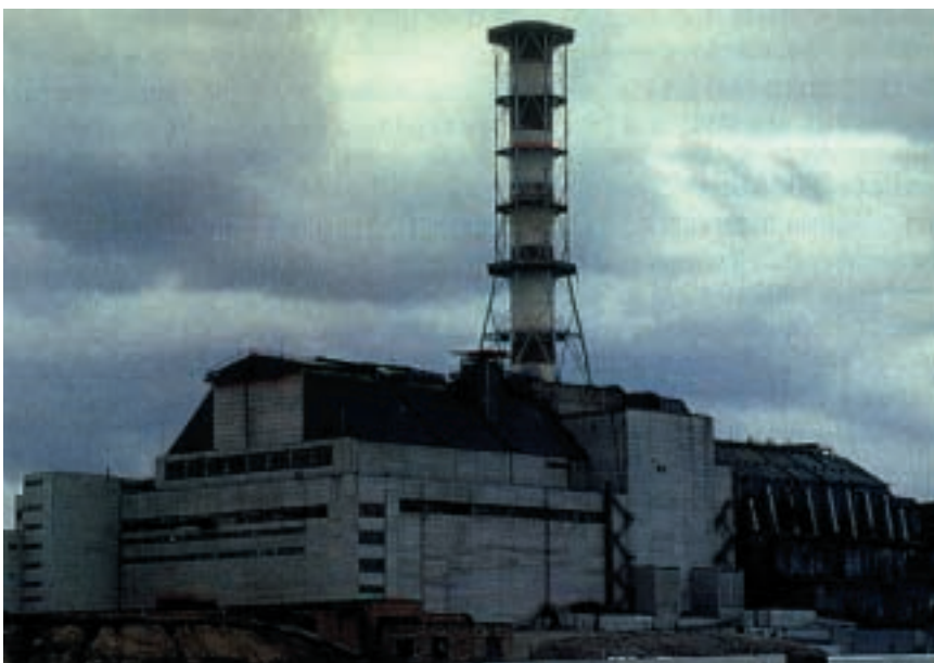
1. LE RÉACTEUR 4 QUI A EXPLOSE est visible à droite, le réacteur 3, à gauche, étant toujours en fonctionnement. Après l'explosion, le réacteur 4 a été recouvert d'un sarcophage qui confine les radio-isotopes les plus dangereux.
