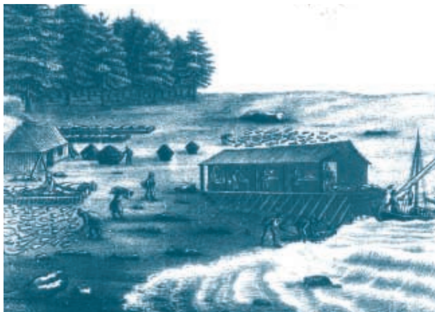
4. LES SÈCHERIES de morue étaient aménagées sur la côte de Terre-Neuve. Le poisson était apporté à terre par chaloupe (à droite), préparé sous le hangar, lavé, salé, puis mis à sécher sur des «échafauds» (à gauche), des plates-formes en bois construites sur pilotis. Après séchage, la morue était embarquée dans des navires qui appareillaient pour la France.
