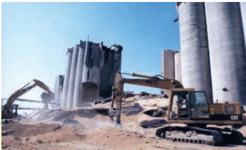
Près de Bordeaux, une explosion de poussières a détruit une dizaine de silos à grains.
