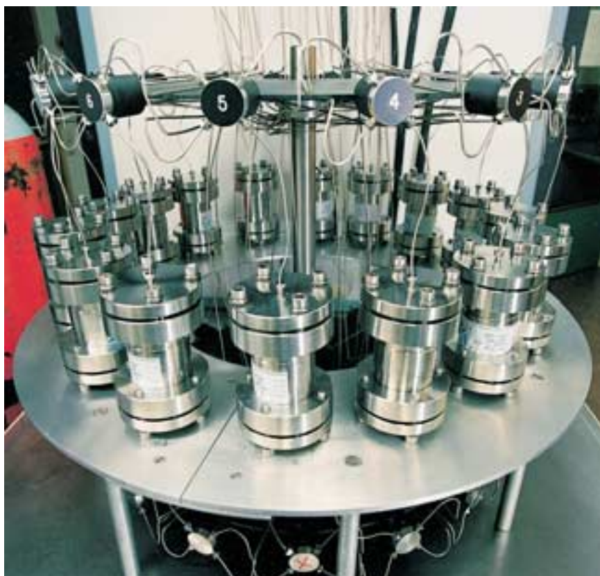
7. DES MODIFICATIONS DES TECHNIQUES chromatographiques permettent désormais de les utiliser pour la séparation à l'échelle de la production industrielle de diverses substances. Dans cette installation de chromatographie à contre-courant simulé de la Société UOP, 16 colonnes sont disposées en série. Le cadencage de l'ouverture et de la fermeture des points d'amenée et de soutirage permet de simuler le mouvement d'une phase solide. On effectue alors une chromatographie en continu qui consomme moins de solvant et évite les pertes dues à la sélection des fractions.
