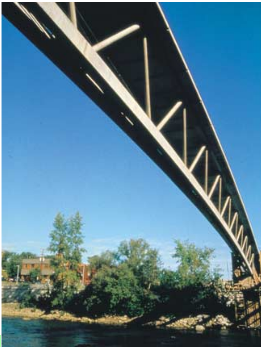
5. CETTE PASSERELLE CONSTRUITE A SHERBROOKE, au Canada, est le premier ouvrage réalisé à partir de «béton de poudres réactives». Dans ce béton, les granulats les plus gros sont des grains de sable. En outre, la porosité est réduite (l'empilement granulaire est optimisé). Après le gâchage et le moulage, on traite le béton thermiquement afin d'activer la réaction pouzzolanique, qui réduit la concentration en chaux et augmente la proportion de silicate de calcium hydraté. De surcroît, des fibres métalliques noyées dans le matériau donnent à celui-ci de une ductilité utile pour la résistance au vent.
