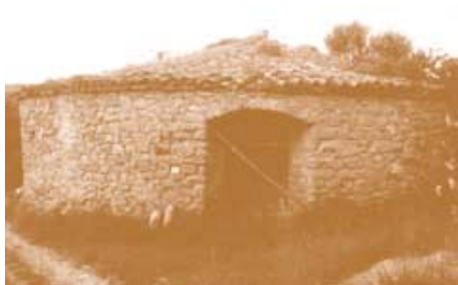
Une des glacières de Pivaut, dans le Var (à droite), date du XVIII e siècle ; elle a une capacité de 900 mètres cubes, des murs de deux mètres d'épaisseur et un unique accès pour la manutention de la glace.
