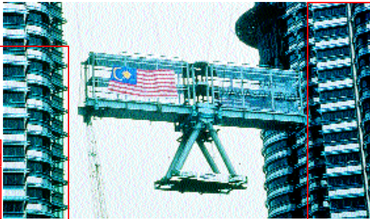
5. LE LEVAGE DE LA PASSERELLE de 325 tonnes a duré trois jours, les équipements de commande ayant été endommagés par la foudre.
