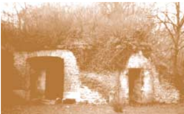
Les glacières que l'on retrouve en France datent généralement des XVII e et XVIII e siècles. Celle de Satory-Versailles (à gauche) date de la fin du XVII e siècle. D'une capacité de 750 mètres cubes, elle a une porte de chargement (à gauche sur la photographie) et deux portes de déchargement (l'une d'elles est à droite sur la photographie).
