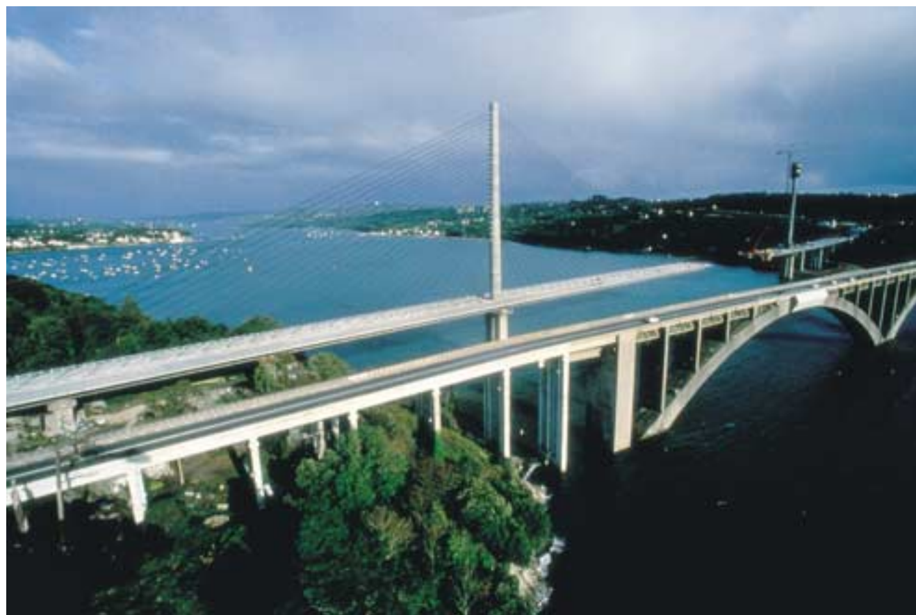
1. CES DEUX PONTS, sur la rivière de l'Elorn, près de Brest, ont été construits à 50 ans d'intervalle. L'allégement de la structure du pont récemment construit, en arrière-plan, montre les progrès du béton : les bétons modernes sont dix fois plus résistants que les bétons du début du siècle.
