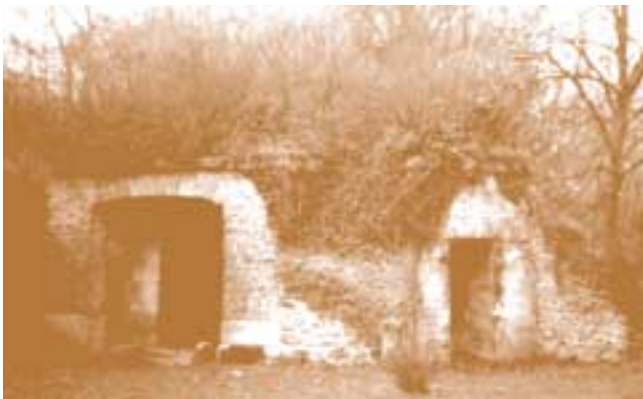
Les glacières que l'on retrouve en France datent généralement des XVII e et XVIII e siècles. Celle de Satory-Versailles (à gauche) date de la fin du XVII e siècle. D'une capacité de 750 mètres cubes, elle a une porte de chargement (à gauche sur la photographie) et deux portes de déchar-
