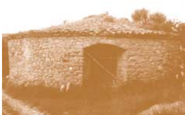
gement (l'une d'elles est à droite sur la photographie). Une des glacières de Pivaut, dans le Var (à droite), date du XVIII e siècle ; elle a une capacité de 900 mètres cubes, des murs de deux mètres d'épaisseur et un unique accès pour la manutention de la glace.
