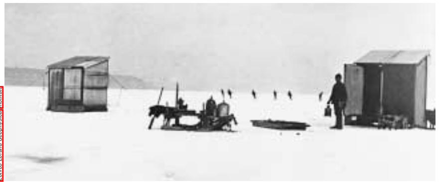
1. LE PREMIER GRADIOMETRE (à gauche), une balance de torsion, a été mis au point par le physicien hongrois Loránd Eötvös, à la fin du XIX e siècle. Pendant l'hiver 1901, Eötvös et ses collègues ont testé cet instrument en cartographiant le fond du lac Balaton, près de Budapest, à partir de sa surface gelée (ci-dessus).
