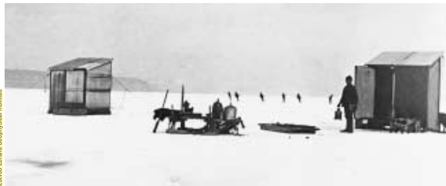
1. LE PREMIER GRADIOMÈTRE (à gauche), une balance de torsion, a été mis au point par le physicien hongrois Loránd Eötvös, à la fin du XIX e siècle. Pendant l'hiver 1901, Eötvös et ses collègues ont testé cet instrument en cartographiant le fond du lac Balaton, près de Budapest, à partir de sa surface gelée (ci-dessus).
