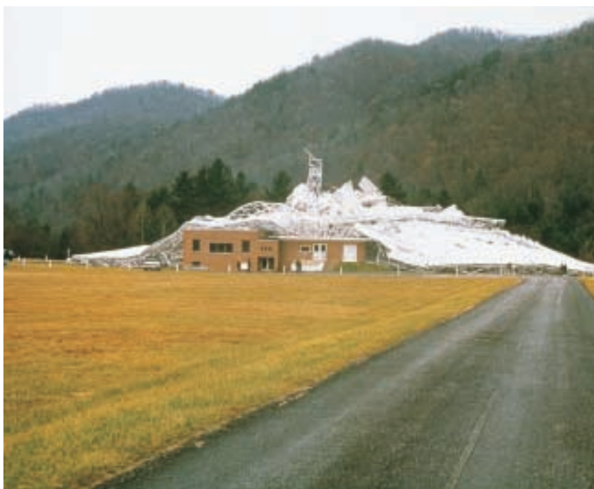
5. CE RADIOTÉLESCOPE de 91 mètres de diamètre ( en haut ) fonctionnait à Green Bank, en Virginie. Le 16 novembre 1988, il s'est effondré ( en bas ) : une plaque métallique du support principal avait cédé. L'antenne sera remplacée par un paraboloïde de 110 mètres sur 100. Contrairement aux antennes circulaires classiques, le nouveau télescope ne possèdera aucun étau de support lui bloquant la vue du ciel.
