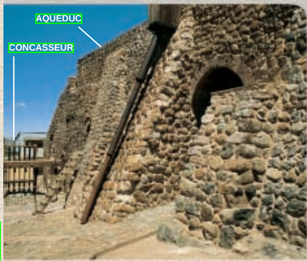
(au centre) qui conduisaient l'eau jusqu'au cœur des usines. L'eau actionnait les concasseurs et elle était également très utilisée au cours du procédé d'amalgamation, qui avait lieu dans des bassins. À droite, un aqueduc restauré et un concasseur (à l'arrière-plan).
