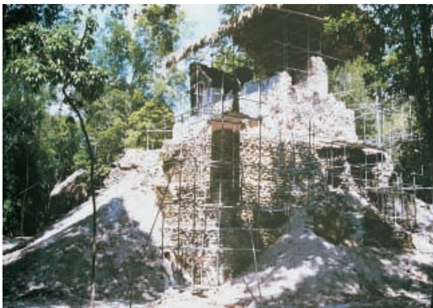
5. CETTE ÉCHELLE très raide (à gauche) mène au temple érigé au sommet de la pyramide principale de Yaxhá : les escaliers existants étaient impraticables, et des travaux considérables furent nécessaires pour stabiliser l'ensemble de la pyramide et du temple, et éviter son effondrement. À Topoxté, on a dû construire un échafaudage autour de la pyramide principale afin d'éviter l'éboulement des murs pendant les travaux (ci-dessus).
