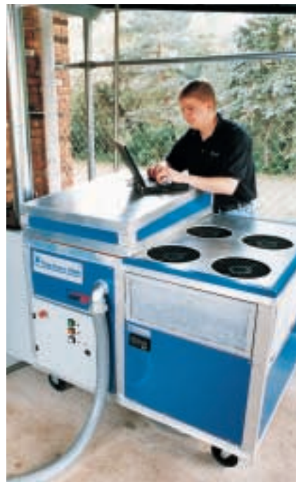
3. UNE PILE A COMBUSTIBLE à membrane échangeuse de protons, de la taille d'un réfrigérateur, installée près du garage, alimente une maison en électricité. Elle fournit sept kilowatts, assez pour couvrir la plupart des besoins de la maison, sauf aux heures de pointe.
