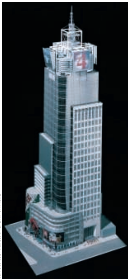
1. CET IMMEUBLE DE NEW YORK est équipé de deux piles à combustible de 200 kilowatts, installées au quatrième étage.
