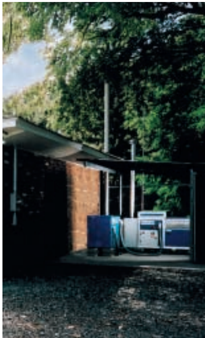
3. UNE PILE À COMBUSTIBLE à membrane échangeuse de protons, de la taille d'un réfrigérateur, installée près du garage, alimente une maison en électricité. Elle fournit sept kilowatts, assez pour couvrir la plupart des besoins de la maison, sauf aux heures de pointe.
