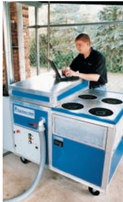
3. UNE PILE À COMBUSTIBLE à membrane échangeuse de protons, de la taille d'un réfrigérateur, installée près du garage, alimente une maison en électricité. Elle fournit sept kilowatts, assez pour couvrir la plupart des besoins de la maison, sauf aux heures de pointe.
