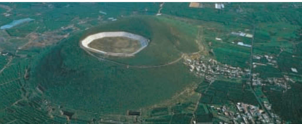
1. LE CRATÈRE du volcan Taco, sur l'île de Ténérife, est tapissé d'un tissu étanche. Il sert de réservoir d'eau pour l'agriculture.
