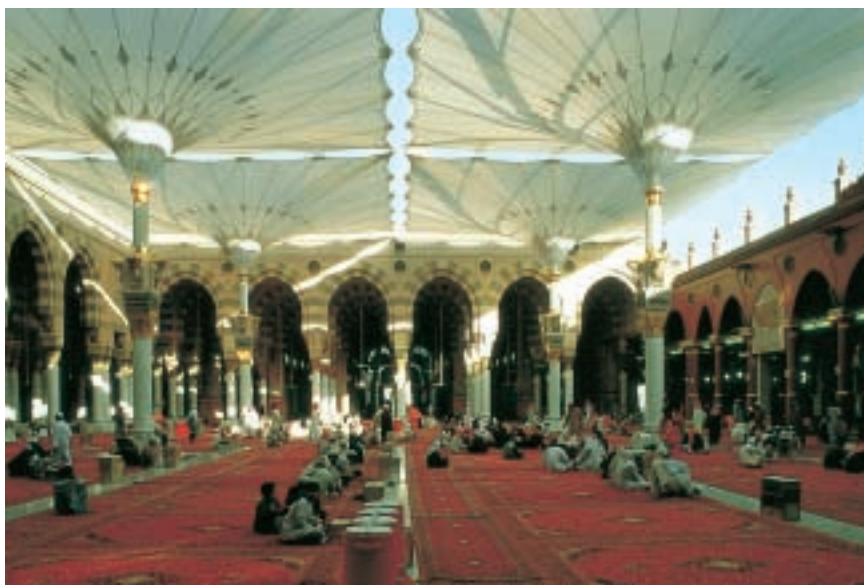
3. DANS LES COURS INTÉRIEURES de la mosquée de Médine, des textiles enduits de polytétrafluoroéthylène protègent les fidèles du soleil, en été. En hiver, les parasols sont fermés le jour et ouverts la nuit, pour retenir la chaleur. Ils se déploient en 90 secondes, grâce à un système de commande hydraulique, et forment un toit à 14 mètres du sol. Les mâts de ces parasols, les plus grands jamais construits, soufflent de l'air frais.
