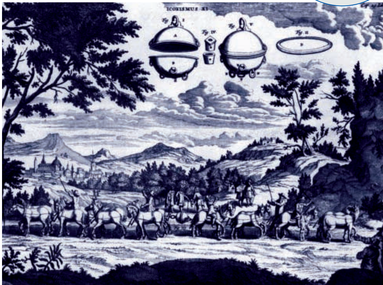
1. L'EXPÉRIENCE DES SPHÈRES DE MADGEBOURG, réalisée en 1654 par Otto von Guericke, mit en évidence «le vide». Après avoir appliqué les hémisphères l'une contre l'autre, von Guericke pompa l'air à l'intérieur. Deux attelages de huit chevaux de trait ne purent les séparer.
