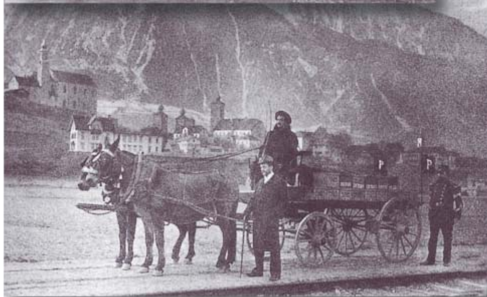
4. Le transport de la dynamite qui servait à progresser au cœur de la montagne était périlleux, même quand l'usine de fabrication de l'explosif était proche de son site d'utilisation.
