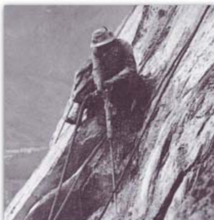
6. Sur le chantier du tunnel du Simplon, les mineurs ont percé les premiers trous de mine, accrochés à la paroi rocheuse par des cordes.
