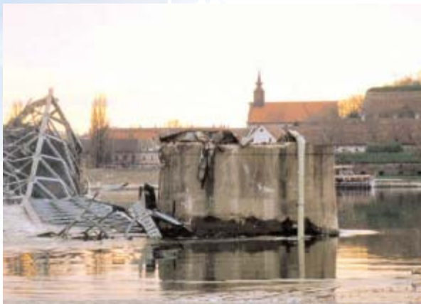
En avril 1999, à Novi Sad, en Yougoslavie, l'attaque aérienne de l'OTAN détruit les installations d'adduction d'eau et le pont sur le Danube.
