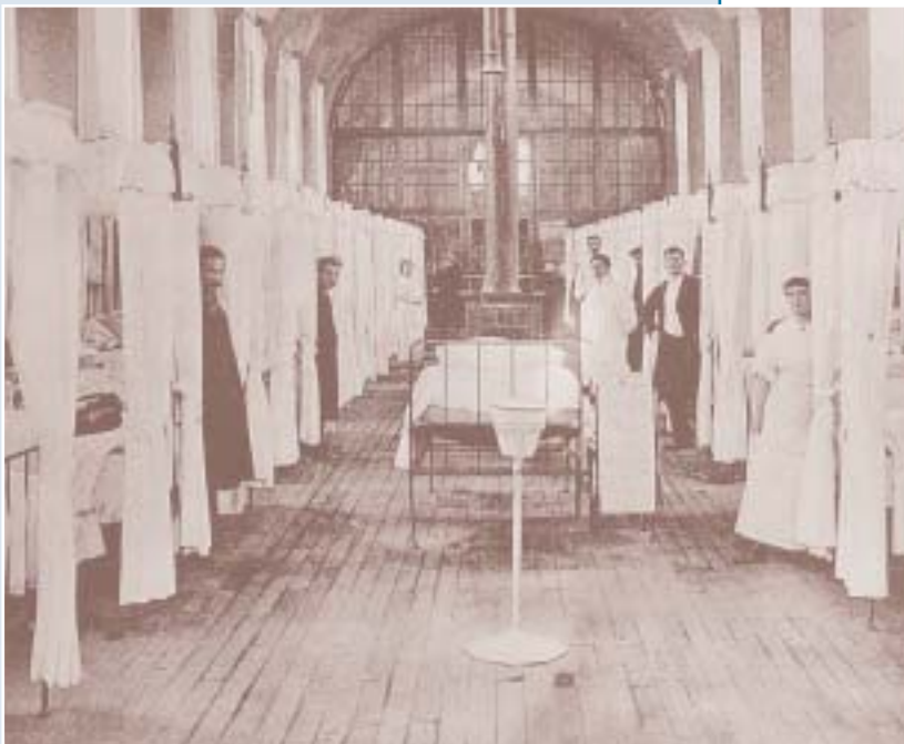
Un crachoir collectif est placé au centre de cette salle de malades, vers 1900. Il était régulièrement stérilisé dans un autoclave.
