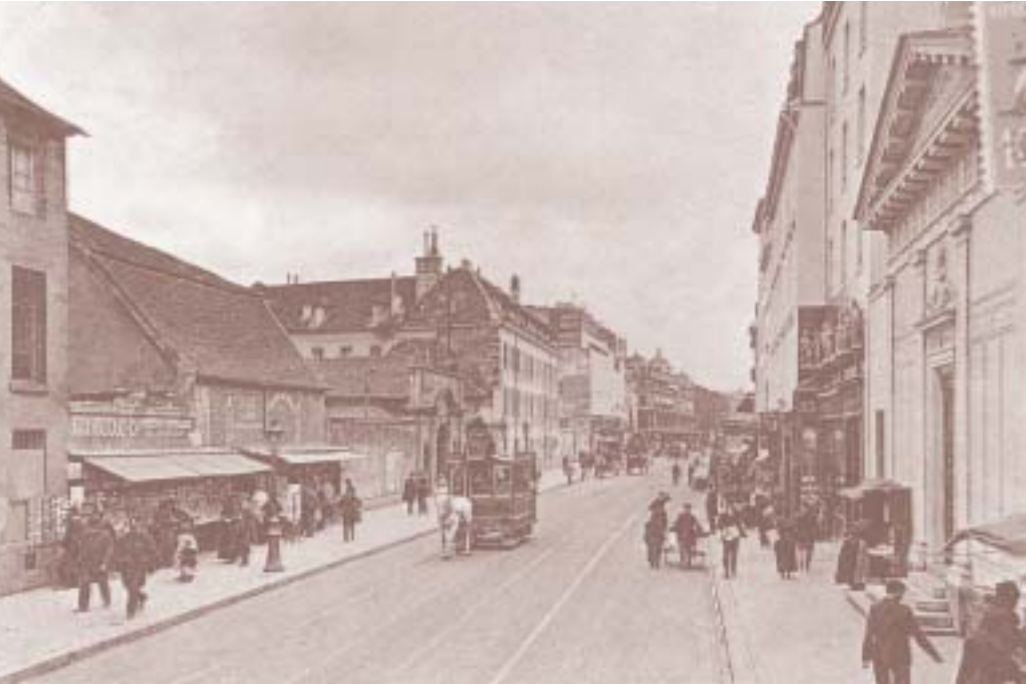
2. ENTRÉE DE L'HÔPITAL, rue de Sèvres, vers 1920.
