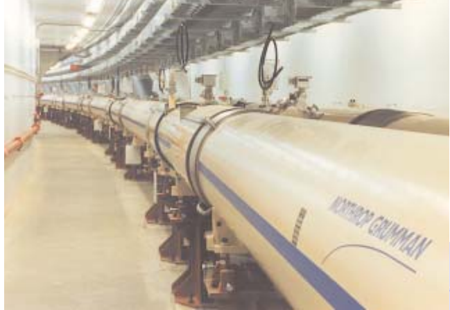
5. L'ANNEAU DU COLLISIONNEUR du Laboratoire de Brookhaven, nommé RHIC, est enfoui dans un tunnel à quatre mètres de profondeur. Des paquets d'ions d'or s'y déplacent à une vitesse très proche de celle de la lumière, en suivant un anneau de près de quatre kilomètres de circonférence.
