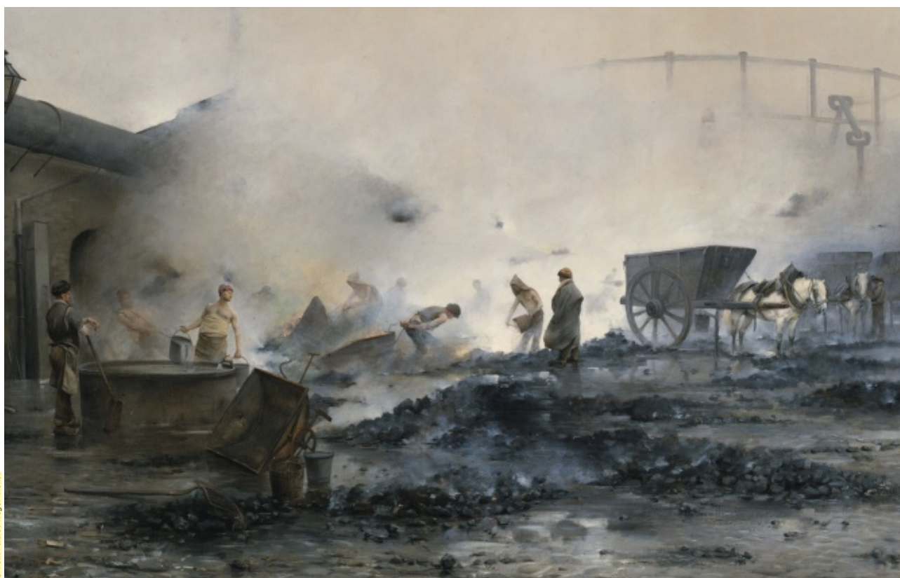
1. L'USINE À GAZ DE COURCELLES , à Paris, huile sur toile d'Ernest-Jean Delahaye (1855-1921). Derrière les vapeurs, on distingue, au fond à droite, la silhouette du gazomètre de l'usine, où est stocké le gaz d'éclairage produit. Celui-ci est fabriqué à partir de houille : chauffé dans des cornues
