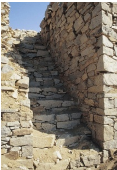
2. CET ESCALIER NORD est l'un des deux escaliers de chaque tour. Leur existence suggère que des activités importantes se déroulaient au sommet des tours.
