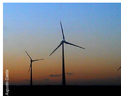
Les éoliennes provoquent des turbulences qui accentuent le brassage vertical de l'air dans leur sillage, et finissent par modifier légèrement la circulation des vents.
