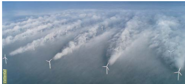
Une éolienne diminue le rendement de celle placée dans son sillage. Les faire tourner en sens inverses améliorerait la situation.
