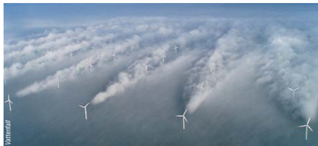
Une éolienne diminue le rendement de celle placée dans son sillage. Les faire tourner en sens inverses améliorerait la situation.
