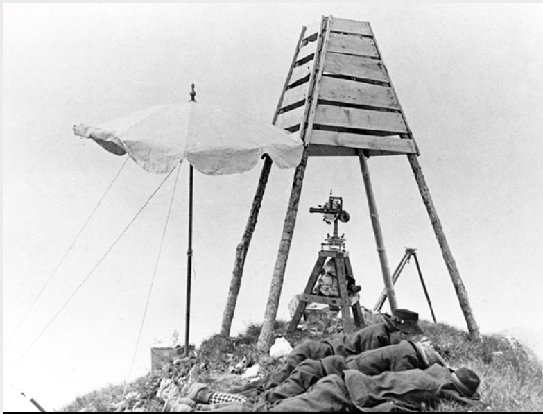
Sous un signal visible de loin (ici en bois), les alpinistes, mesures accomplies, se reposent près d'un théodolite (instrument mesurant des angles dans les plans horizontal et vertical afin de déterminer une direction) et d'un parasol visant à éviter les reflets.
