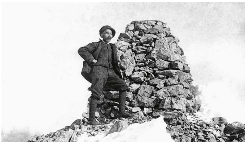
PAUL HELBRONNER , en 1921, sur la pointe Durand, au Pelvoux, dans le massif des Écrins. Un signal en pierre y a été érigé pour faciliter la visée du sommet lors des mesures de triangulation à partir des sommets voisins. Une étape indispensable du projet de cartographie du géodésien.
