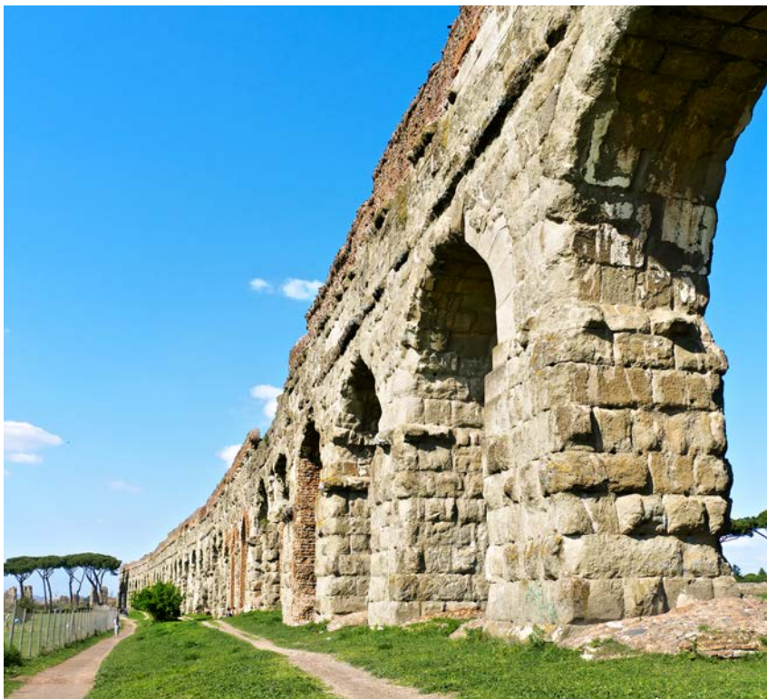
Les roches volcaniques dont sont constitués l'aqueduc de Claude à Rome (ci-dessus) et la voie Appienne (à droite) proviennent soit de tufs (débris volcaniques consolidés), soit de coulées de lave des monts Albains. Elles ont fourni des informations sur l'histoire éruptive de cette zone volcanique.
